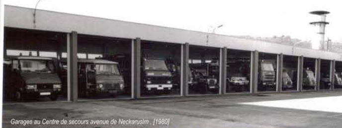
Garages au Centre de secours avenue de Neckarsulm. [1980]
